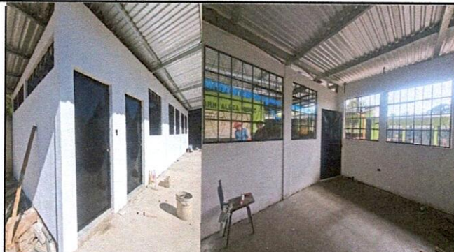
Foto 2: Fabricación e instalación de ventanas y puertas en módulo de un aula, dirección y baño.
