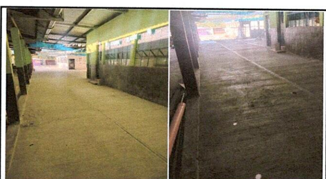
Foto 6: Reparación de piso de torta de concreto frente al aula de tercero y aula tecnológica.
