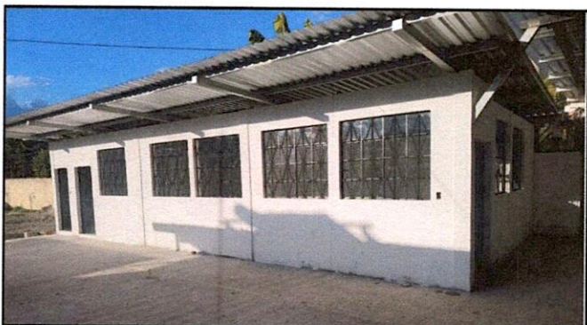
Foto 3: Colocación de entechado de módulo de un aula, dirección y baño.
